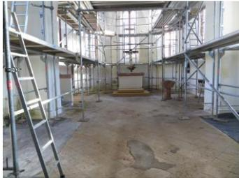
Nach Abstimmungen mit Denkmalschutz, kirchlichen Baupfleger und den Gewerken, erfolgen jetzt die Arbeiten. Neben einem neuen Fußboden aus Plattenbelag, der Überarbeitung von Innenputz, Decke und Empore, erhält das Kirchenschiff wieder einen Mittelgang, wie bis Ende der 50ziger Jahre vorhanden. Dazu werden die Bankreihen entsprechend aufgearbeitet und angepasst.
